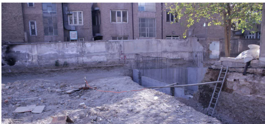
پروژه استخر در حال احداث دانشگاه تهران
